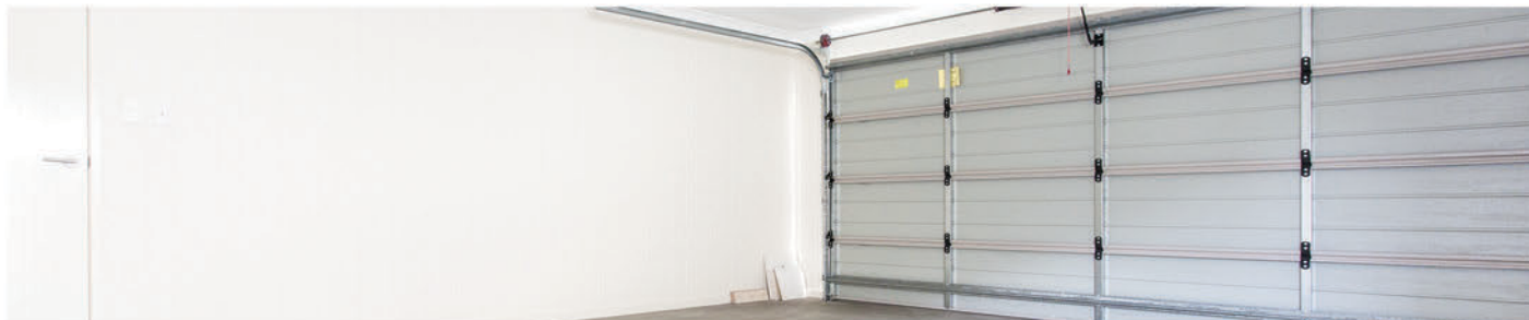
Riedmühlepark, Dietlikon, Allianz Immobilien, Garagenabdichtung
