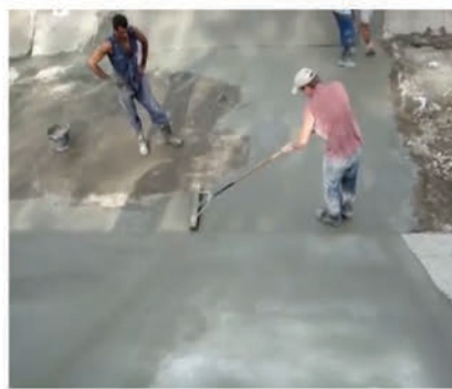
BETONSANIERUNG UND ABDICHTUNGSARBEITEN
