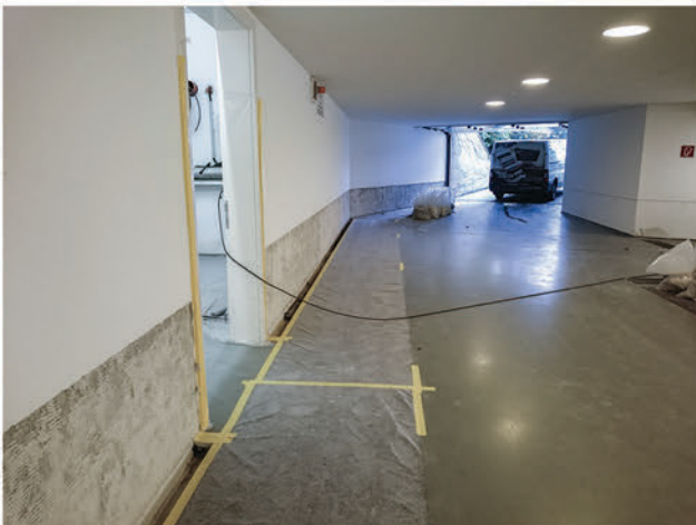
NCT-Dichtkeil-System – nachträgliche Abdichtung einer Neubaugarage in 1190 Wien.
