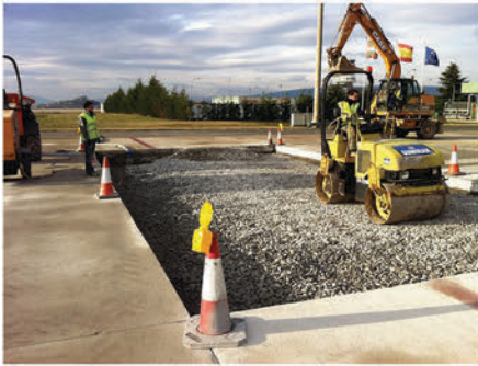
LANDEBAHN VITORIA - NEUBETONIERUNG UND SANIERUNG
