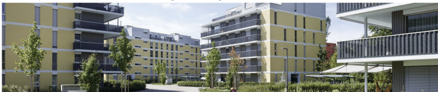
F & B Bau AG, Ilkau, Garagenabdichtung
