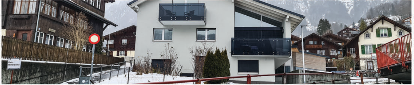
Kellerabdichtung, Trachtlistrass, Brienz
