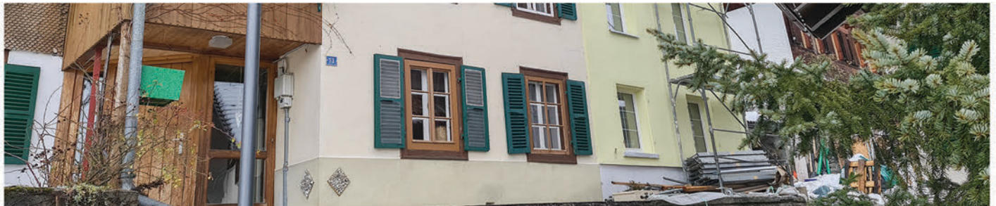
Miethaus, Garage, Neubau - nachträgliche Abdichtungsarbeiten, Furttalstrasse, Zürich
