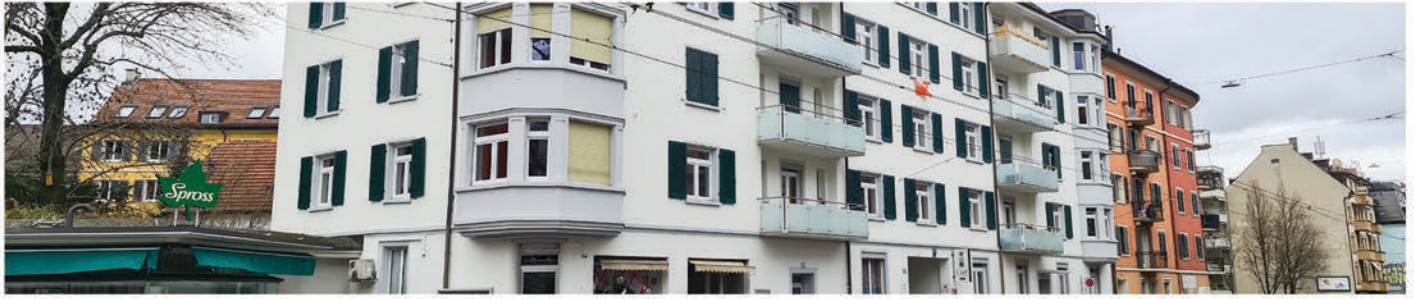
Einfamilienhaus Sanierung, Zürich
