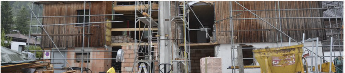
Architekt Dipl. Ing. Flatz, Außenwand-Sanierung, Wolfurt, 2016
