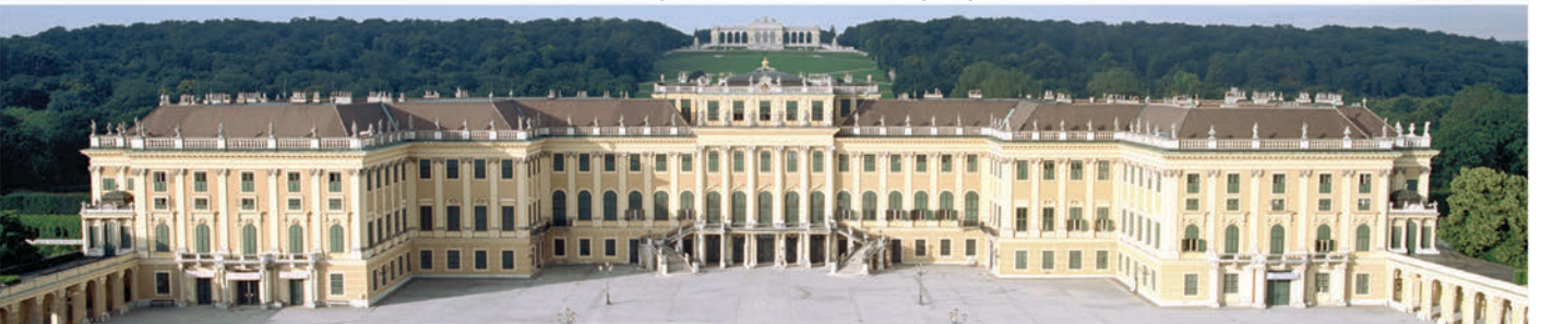
Hofer, Wien, Kellerabdichtung, 2017
