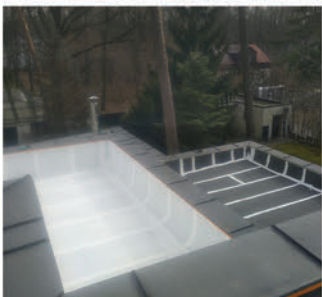
Nach dem Austausch der Dachhaut
