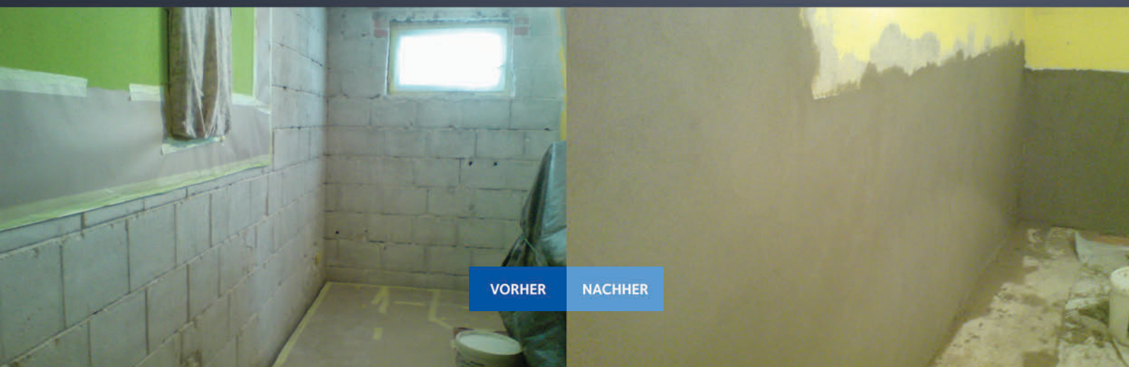
Schalsteinmauer - und Dichtfugensanierung, Abdichtung, Simmeringer Haide, 1110 Wien, Hr. Holsan
