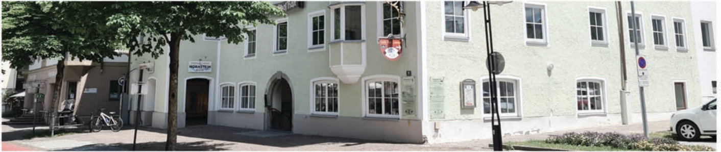
Sandoz Austria, Mauerabdichtung - Feuchtmauersanierung, 2020
