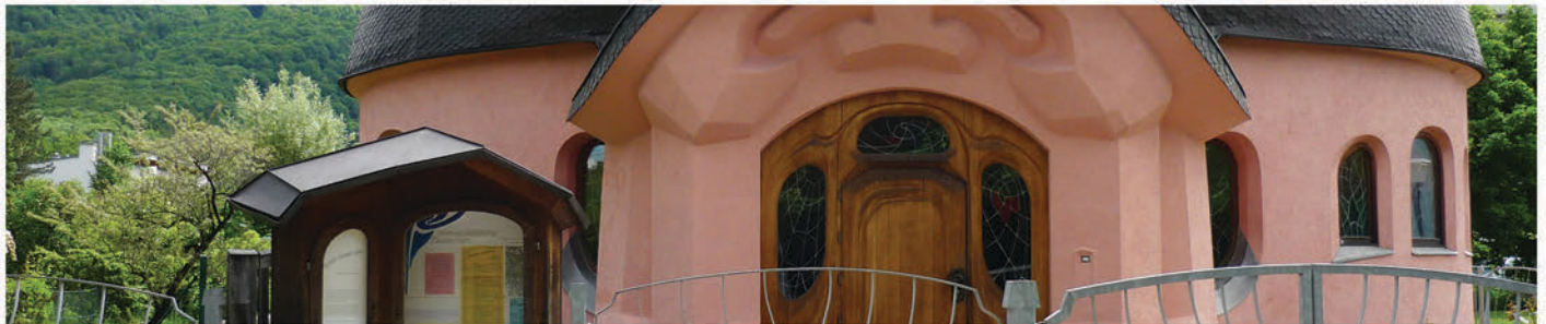
Katholische Pfarrkirche Breitenfurt-St. Bonifaz, Sanierungsarbeiten, 2384 Breitenfurt bei Wien, 2018
