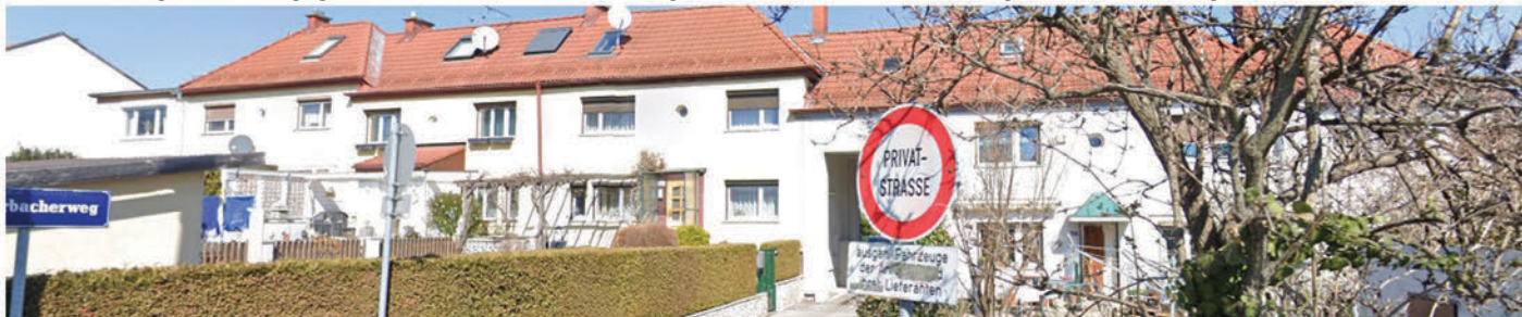
Bildungszentrum Kenyongasse, 1070 Wien, Div. Mauertrockenlegungsarbeiten 2016 - lfd.
