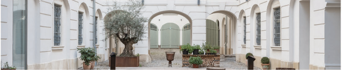
Tribüne Kriau, Wien, 1200 m 2 Abdichtung und Bodenarbeiten, 2002
