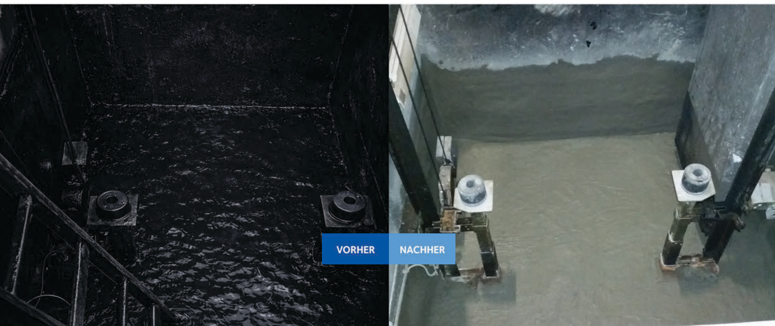
Aufzugabdichtung, Firma Heidenreich BAU, Ing. Aleksandar Matic
