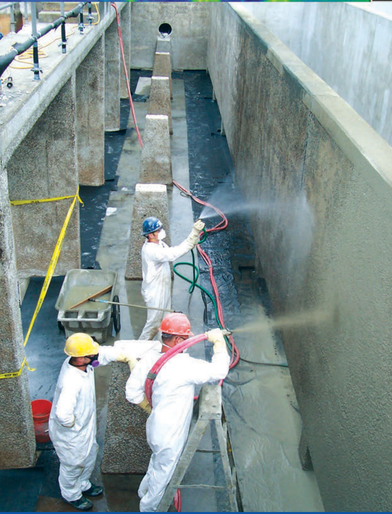
Kläranlagen und Wasserbehälter Sanierung
