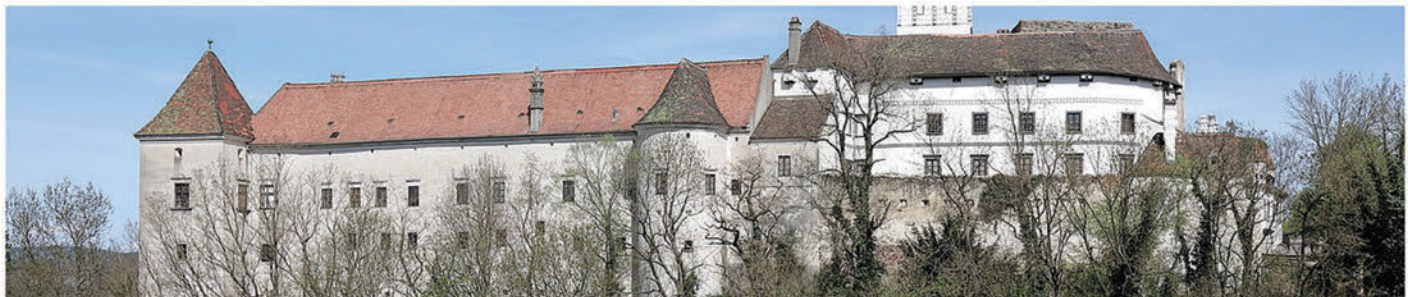
Kartause Gaming, Bodenabdichtung und Verlegung, 2011
