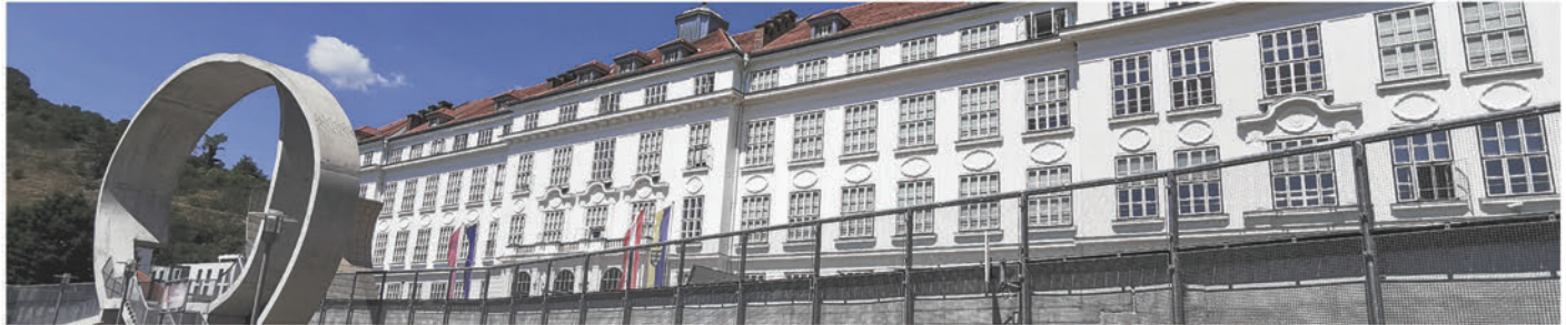
Schloss Schallerburg, Abdichtung, Bodenarbeiten, 2011
