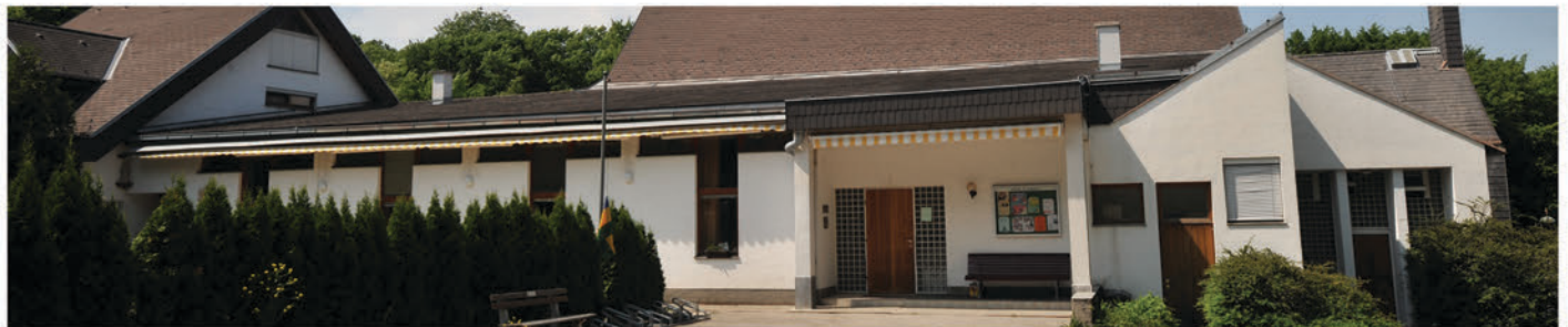
Pfarre Perchtoldsdorf, 2380 Perchtoldsdorf, Abdichtungsarbeiten - aufsteigende Feuchte, 2018
